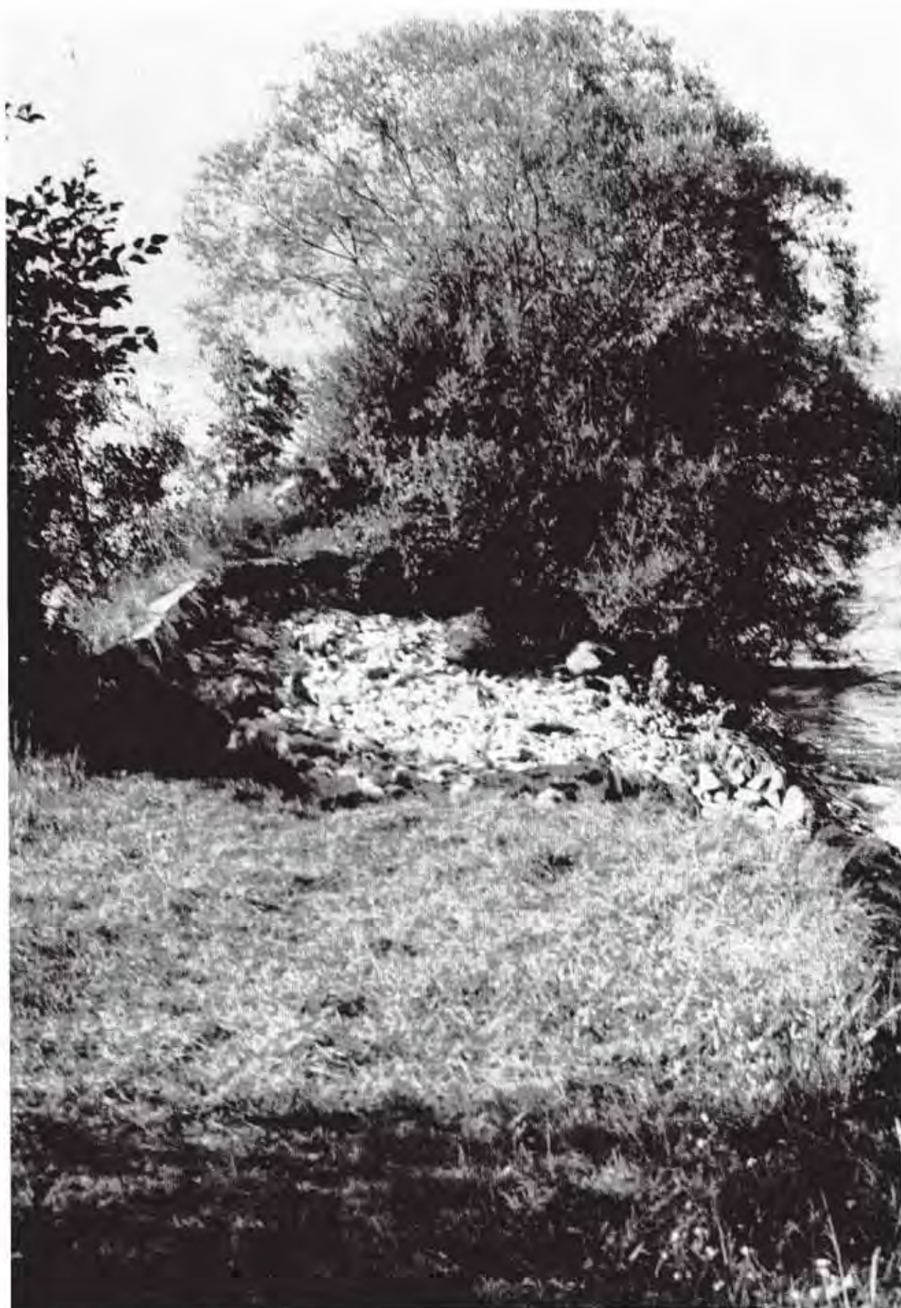
Abb. 5.6. Der Reussdamm zerfällt, weil sein Fundament abgegraben wurde
