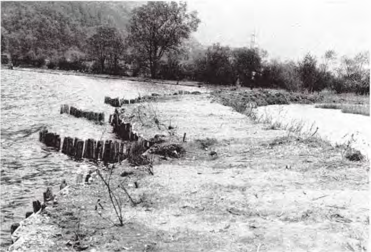
Abb. 4.5. Im Jahr 1982 wurde der Schutzwall durch Pfahlreihen, Drahtgeflecht und Vliess verstärkt und mit Weiden bepflanzt
