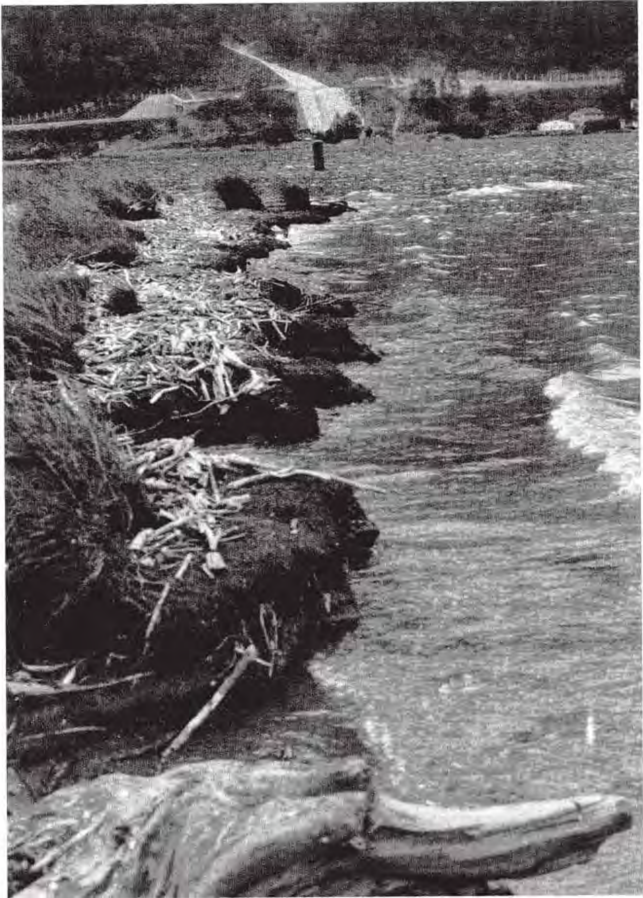
Abb. 3.26. Schäden am Seeufer durch den ungebremsten Wellenschlag am Seedorfer Ufer
